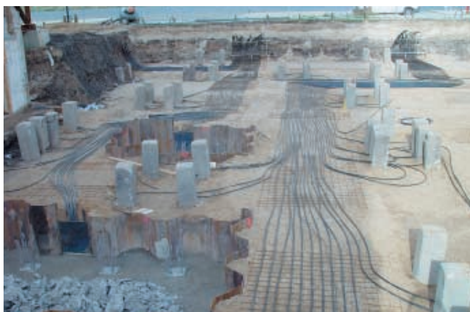
Abb. 5: Baufeld mit eingebrachten Energiepfählen und Horizontalanbindung
